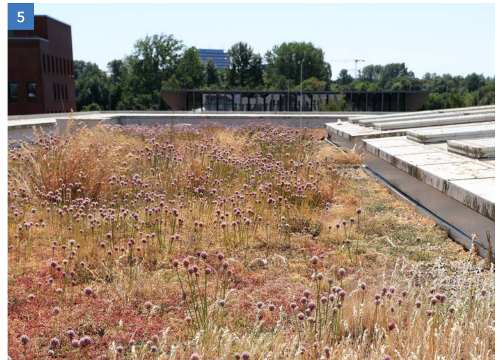
Abbildung 5: Das Dach vom Juridicum der CAU wurde begrünt.
