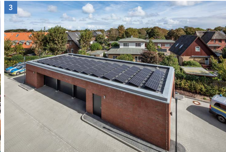
Abbildung 3: Photovoltaikanlage auf der Garage vom Polizeirevier Westerland.
