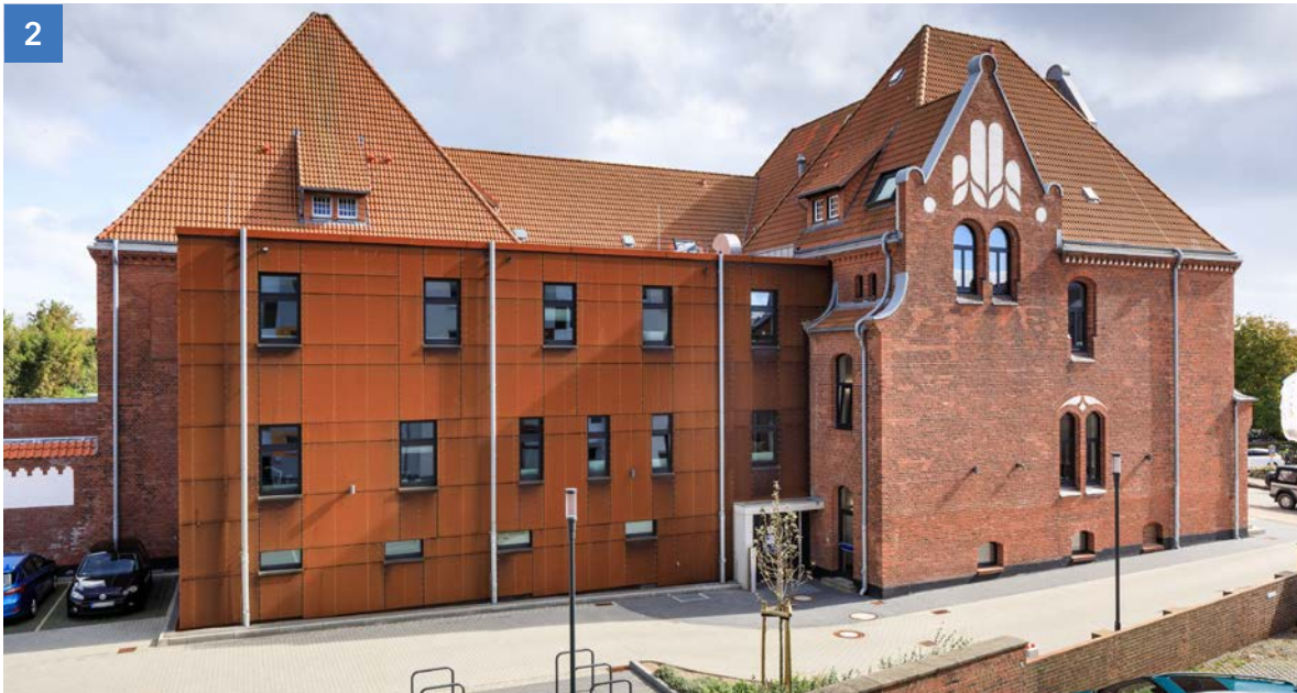
Abbildung 2: Polizeirevier Westerland, Grundsanierung und Erweiterungsanbau.
