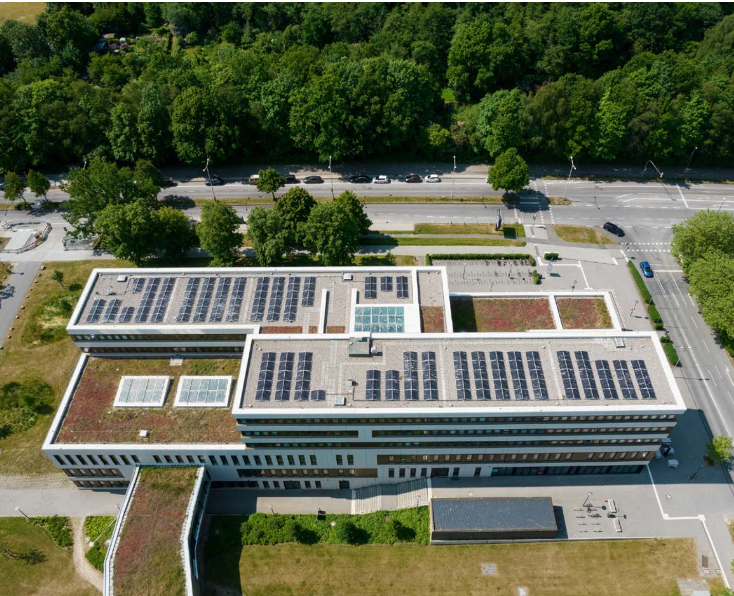
Abbildung 1: CAU Juridicum, Dachbegrünung und Photovoltaikanlage
