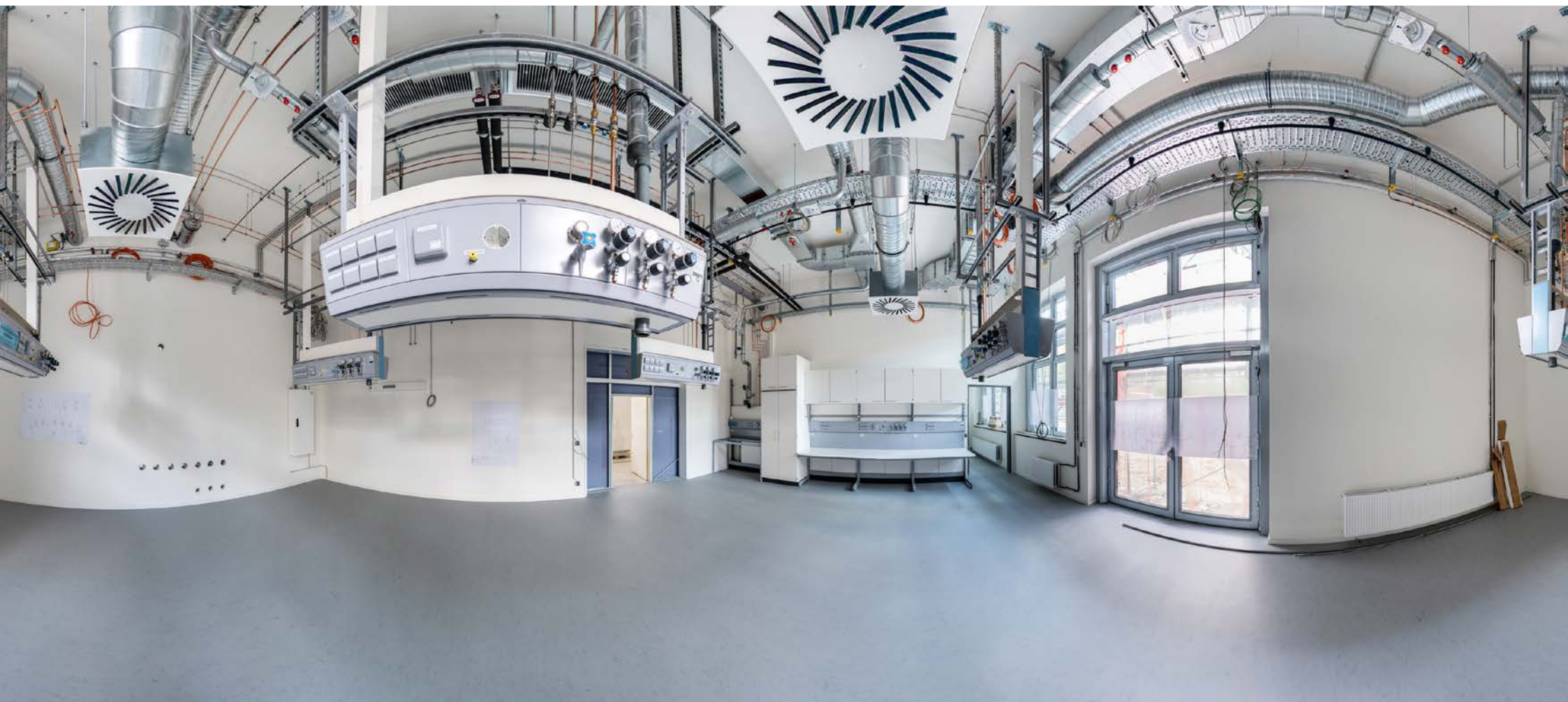
Abbildung 14: Baustelle ZEVS, Labor, Panoramafoto
